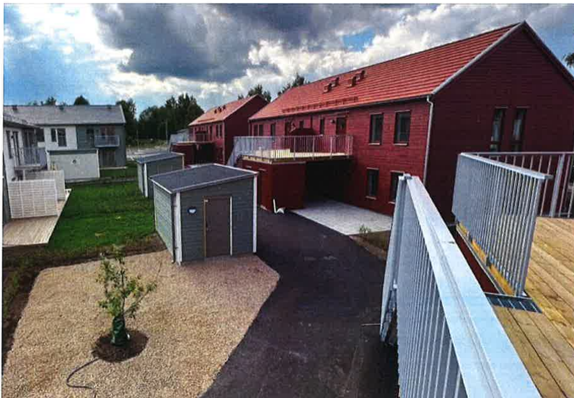
Figur 2 b. Nyuppförda hus i Herrljunga som överensstämmer med fasadritningarna i Figur 2 a.
