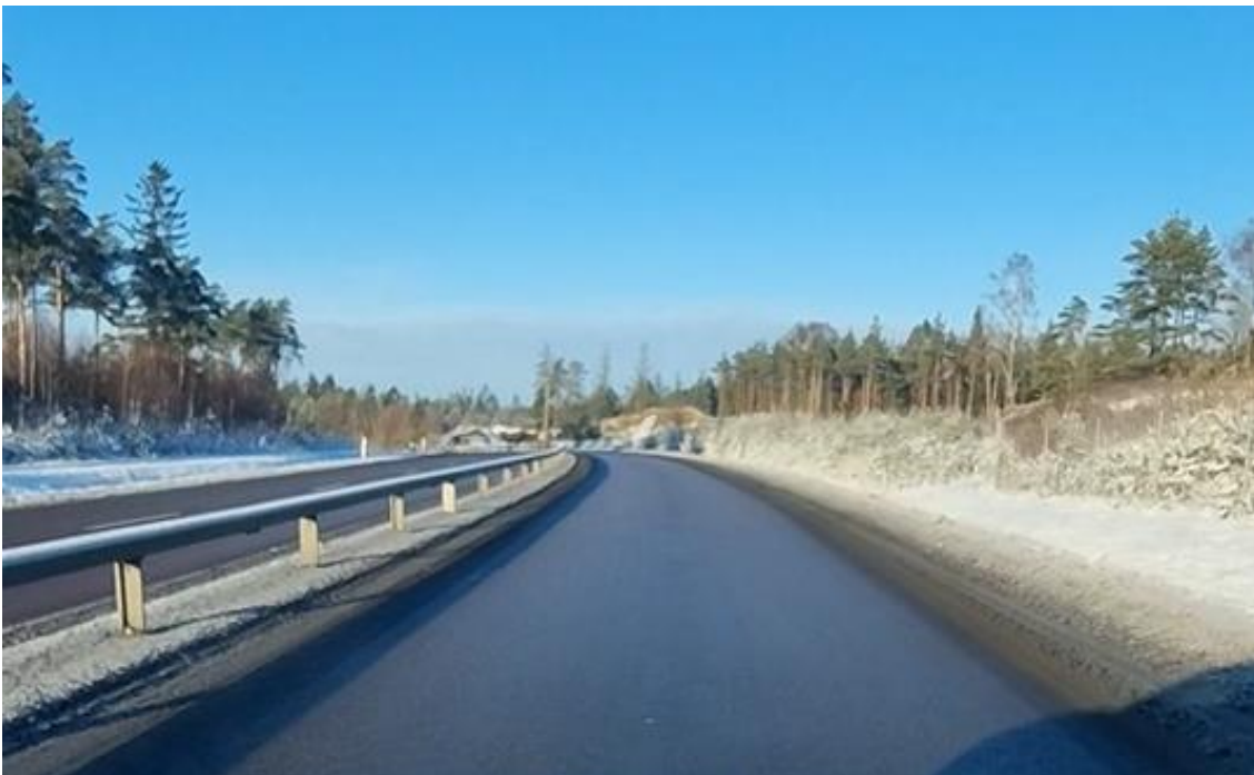
Figur 9. Väg 535, delsträcka med 2+1-väg.
