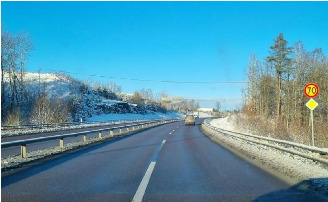
Figur 8. Väg 535 utgörs av 2+2-väg med räckesseparering mellan Bårhultsmotet och cirkulationsplatsen vid Fläskebovägen.
