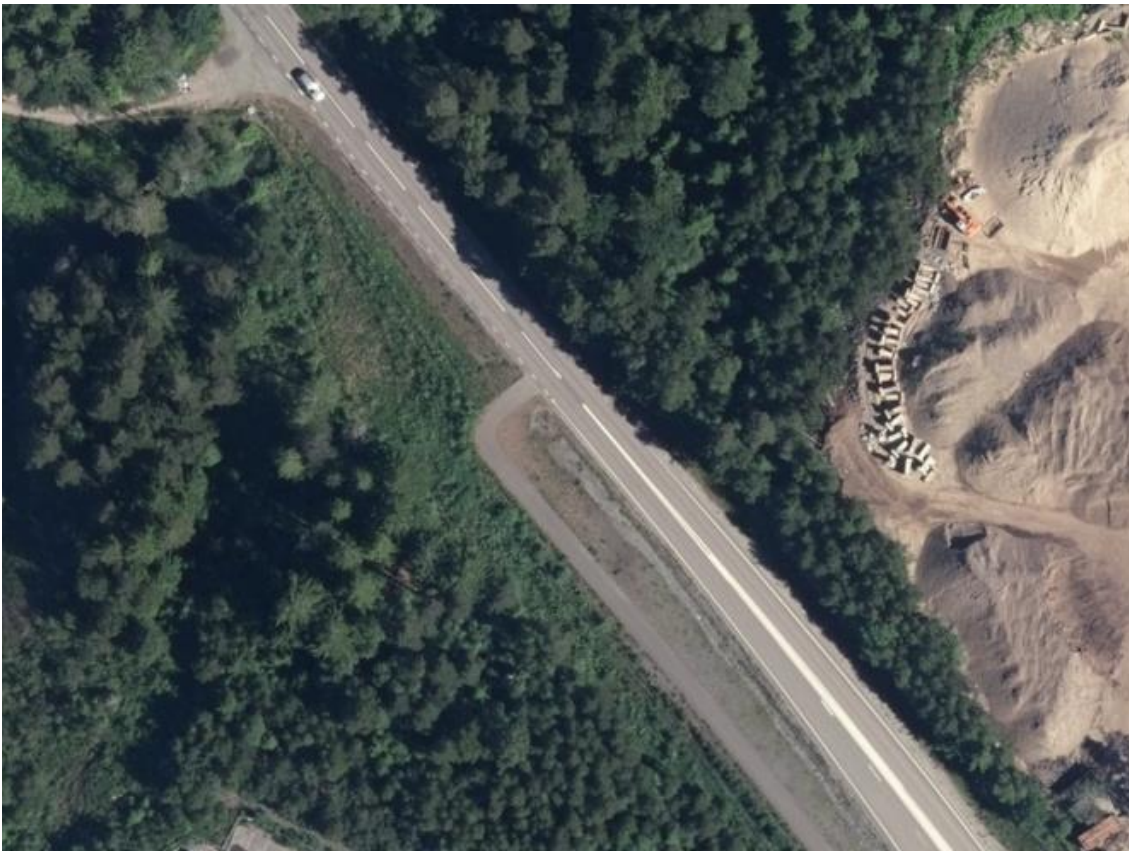
Figur 18. Bild över avslut på gång- och cykelbana längs med väg 535 västra sida, cirka 300 meter söder om planområdet.
